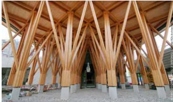
La demande en produits industrialisés est de plus en plus importante dans le domaine de la construction. Les bois collés (BLC, BMR) offrent en la matière des solutions pour les moyennes et grandes portées. Les caractéristiques de résistance mécanique et de durabilité ouvrent au douglas, essence qui se prête bien au collage, de belles perspectives en la matière.
