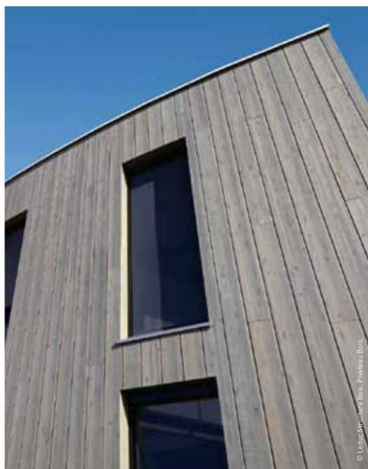
Bardage avec finition (lasure semi-transparente).
